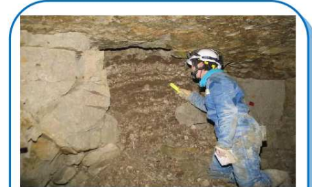
Reconnaissance visuelle d'une cavité souterraine
