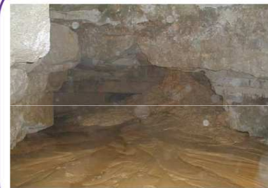
Comblement par coulis de silicates
