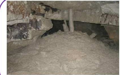
Comblement par déversement gravitaire
